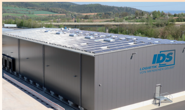
Versorgt sich nahezu selbst mit Sonnenstrom: Das IDS Zentral-Hub im hessischen Neuenstein
