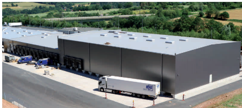
Die neue Umschlaghalle des IDS Zentral-Hubs in Neuenstein
